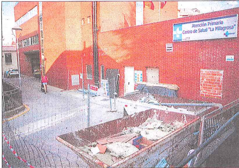
Las obras para un acceso directo de urgencias desde la calle Nicolás Rabal. MONTESEGUROFOTO
