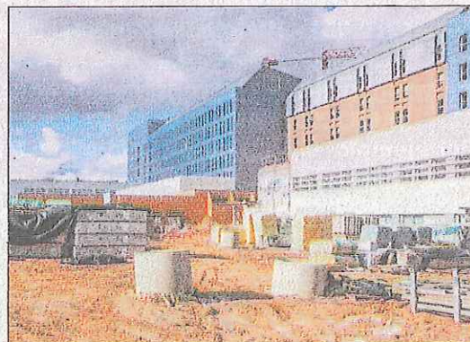
El Hospital Santa Bárbara en obras. M.T.
